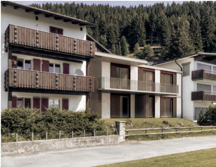
Umbau im Bestand Rigi Kaltbad
